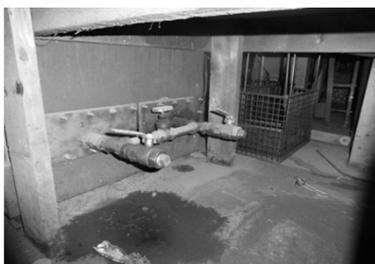
La foto n.1 mostra il serbatoio utilizzato. Si evidenziano le valvole di scarico poste sul fondo del serbatoio.
